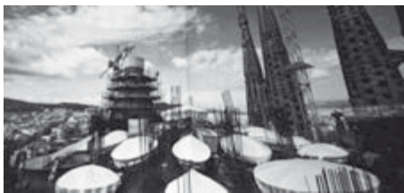
Figura 30. Infraestructura de hormigón armado como base del cimborrio principal.
