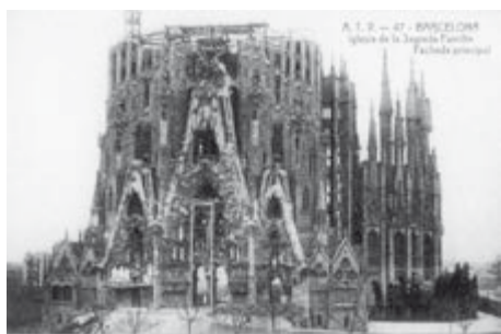
Figura 20. Fachada del Nacimiento en construcción con los tres Portales de la Esperanza, la Caridad y la Fe.
