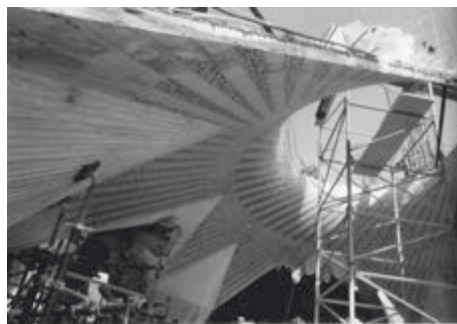
Figura 27. Lucernario de la nave central, realizado con la llamada «volta catalana» y con revestimiento de cerámica dorada de Manises.
