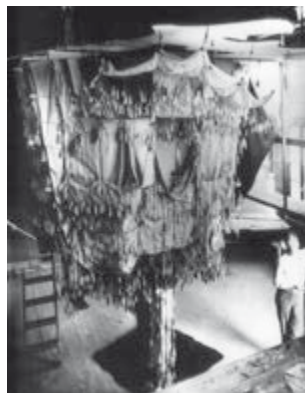
Figura 14. Prueba de carga para las bóvedas realizada por Gaudí.
