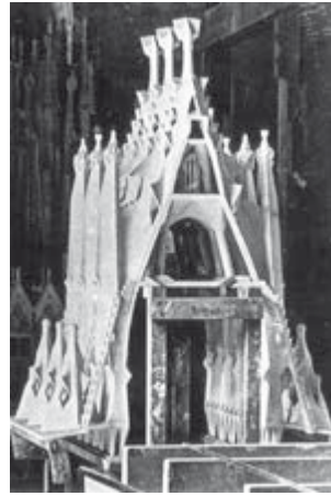
Figura 35. Cubrición del cuerpo de naves (maqueta realizada por Gaudí).
