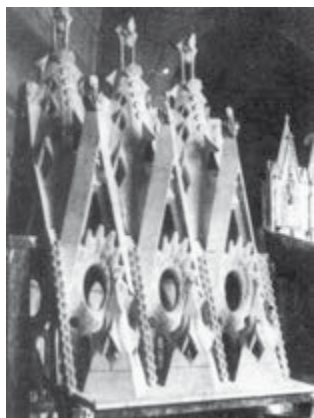
Figura 26. Modelos de yeso de la cubrición de las naves.
